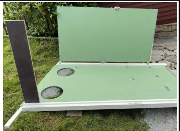
6. Rückwand positionieren und anschrauben Schrauben aus Packung A: Euroschrauben
