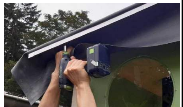
Straffziehen und festschrauben
