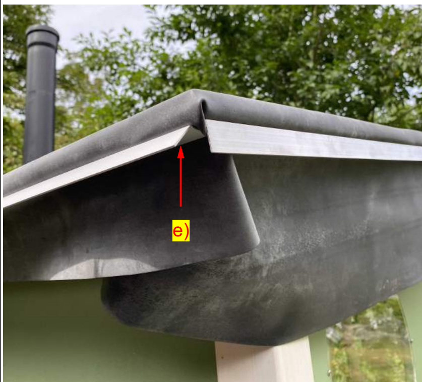
Straffziehen und festschrauben
