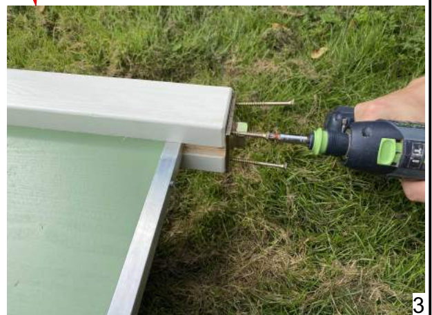
1. Pfostenträger montieren Schrauben aus Packung B: 6x80 mm
