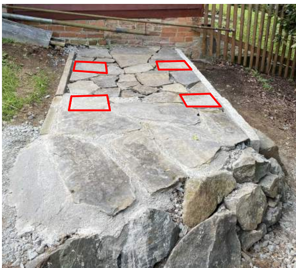
Beispiel Punktfundamente
