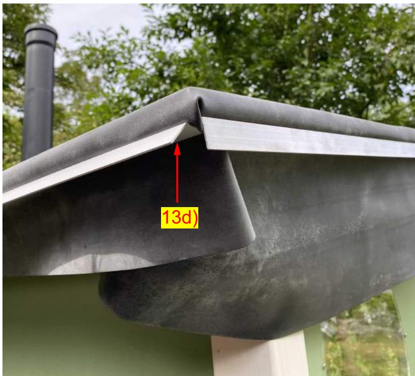
Straffziehen und festschrauben
