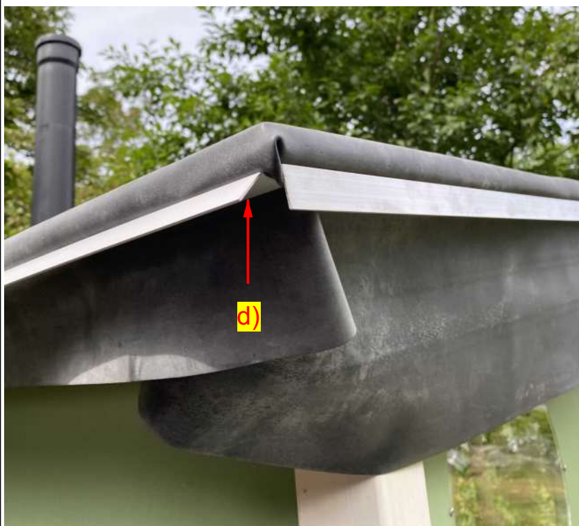
Straffziehen und festschrauben
