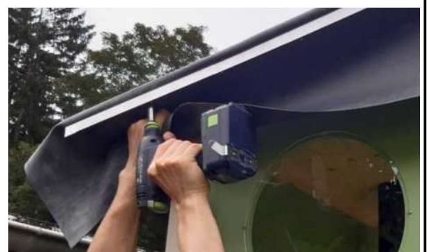
Straffziehen und festschrauben
