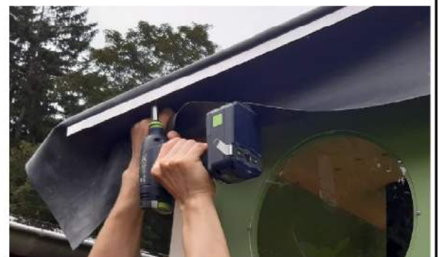
Straffziehen und festschrauben
